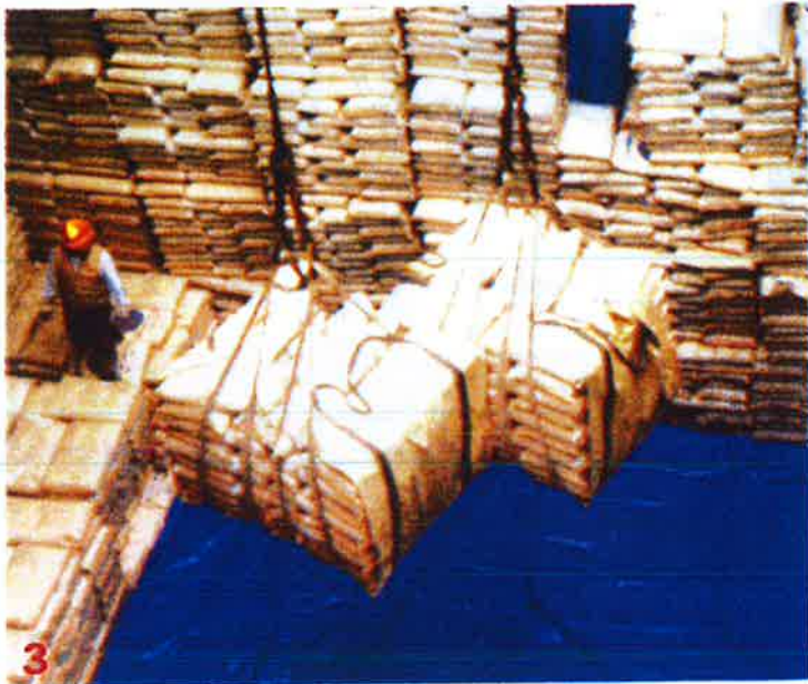
クレーンにつりベルトを掛けて搬送します。
